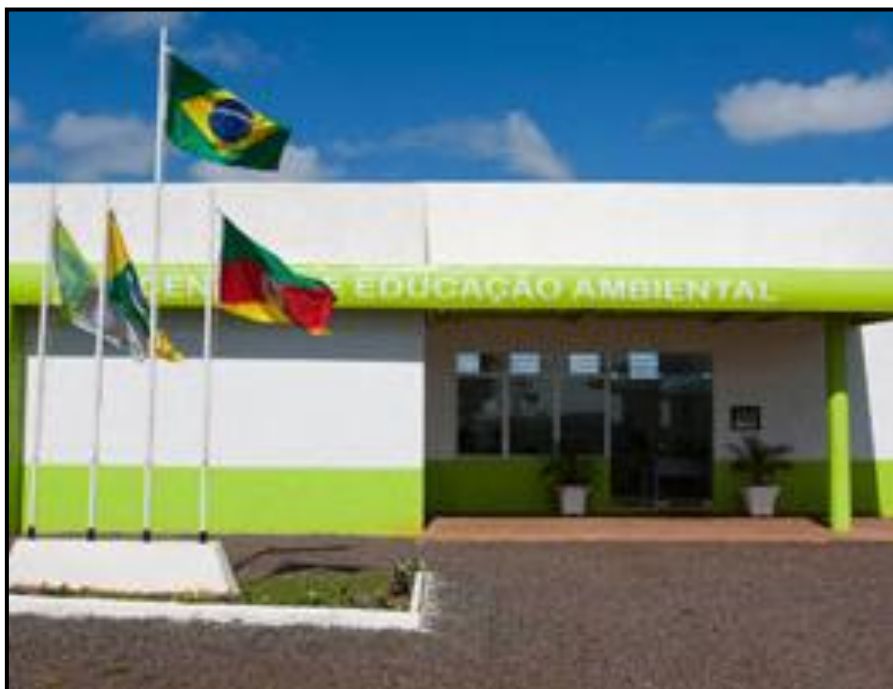
Figura 24: Aterro Sanitário de Giruá – RS – Centro de Educação Ambiental
