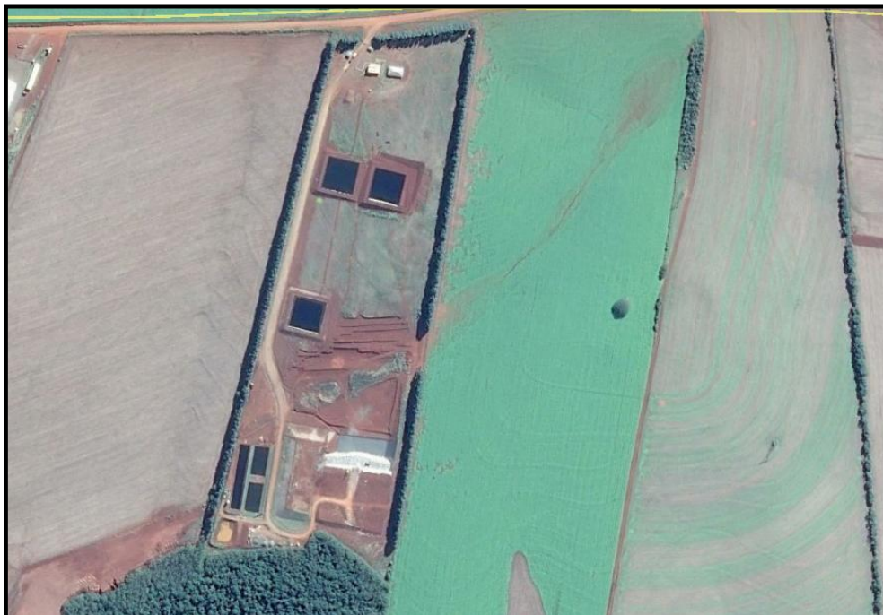
Figura 21: Aterro Sanitário de Giruá – RS – Vista Aérea
